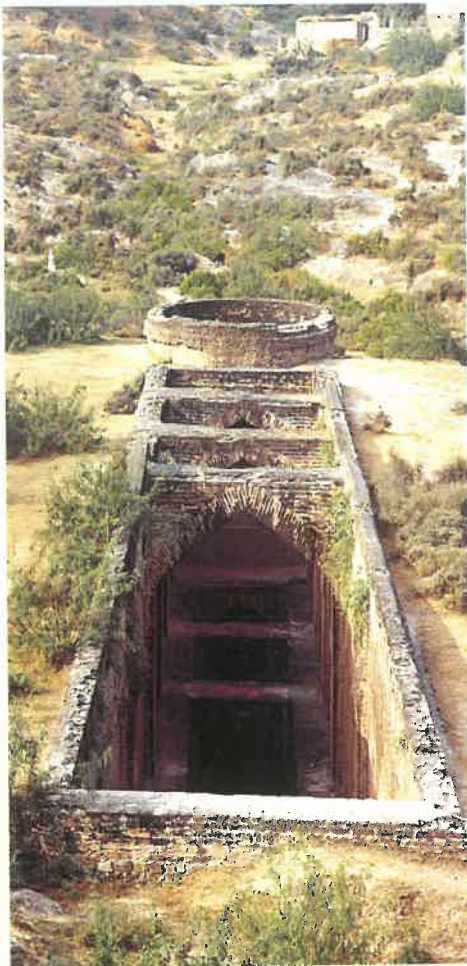
Baoli inside Rohtas Fort
